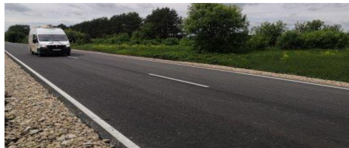
Ремонт участка дороги Бутурлино — Сурадеево — Гагино
