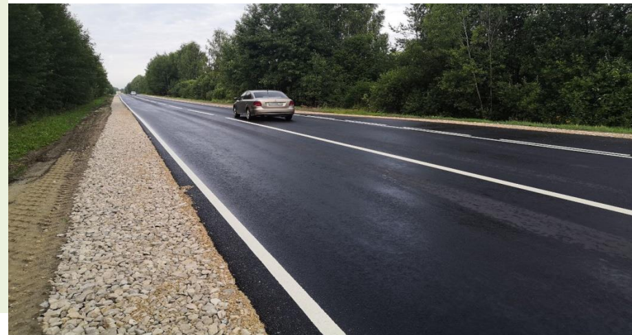
Ремонт участка дороги Линда — Городец — Заволжье
