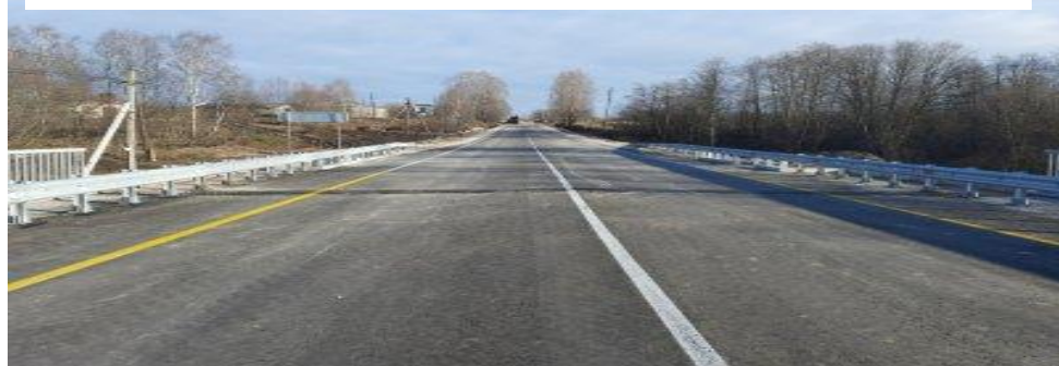
Новый мост через реку Санахта в Чкаловском районе
